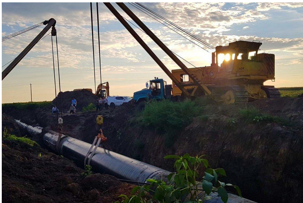
Рис. 1.2. Ремонт магістрального трубопроводу [6]
