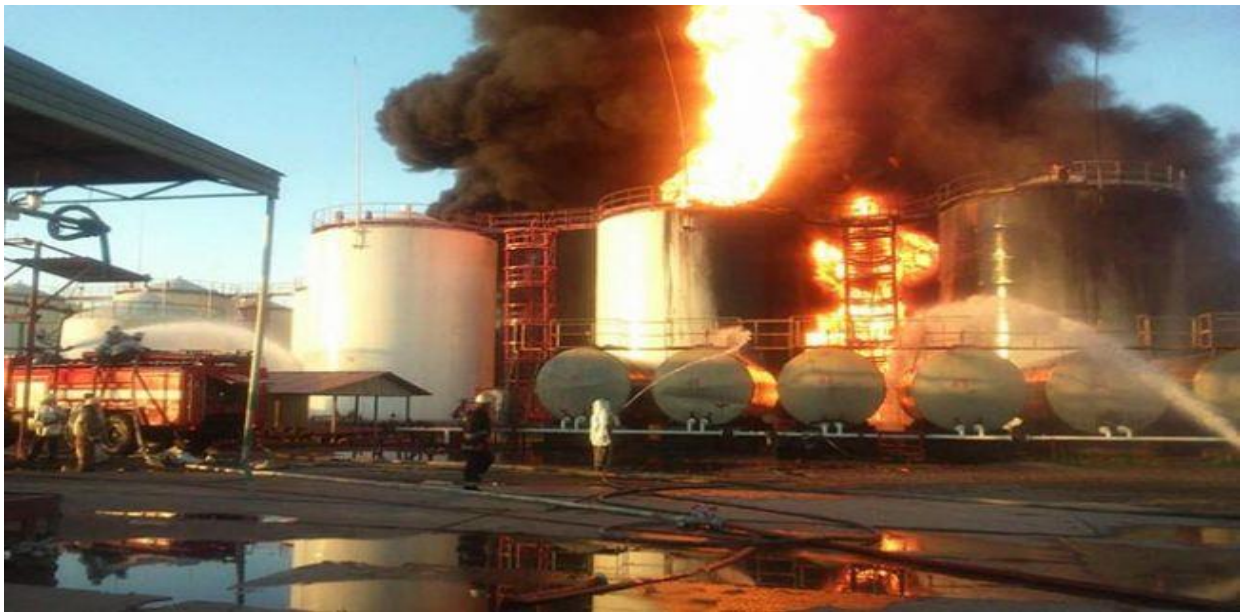
Рис. 1.3. Пожежа в резервуарах на нафтобазі
